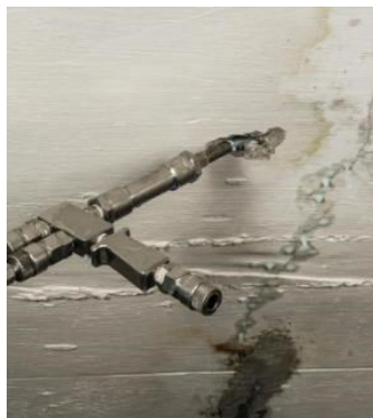
Foto: Injeção de gel vinílico Fonte: Impermaster- Arqº Daniel Montes
