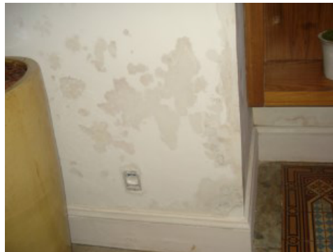
Foto: Umidade ascendente
