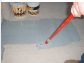
Fotos: Execução da camada impermeável com membrana acrílica- Icopor HP Fonte: Icobit — Ronaldo Mendonça
