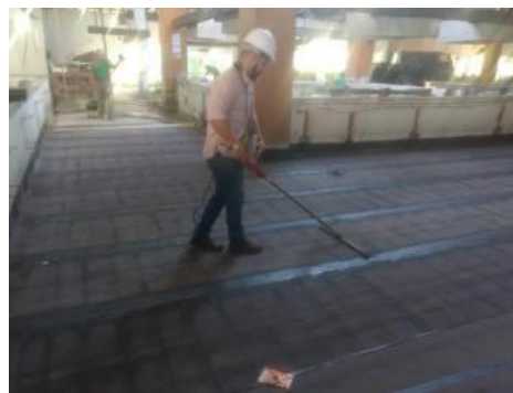
Foto 2: Ensaio de estanqueidade a seco, com equipamento Detector de descontinuidades – Holiday Detector
