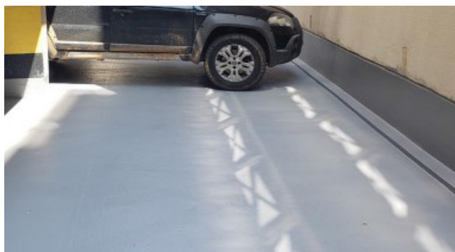
Foto: Sistema de impermeabilização para trânsito de veículos
