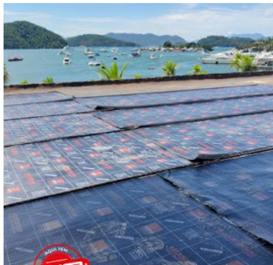
Fotos: Faixas de emenda da manta asfáltica Fonte: Texsa Brasileira
