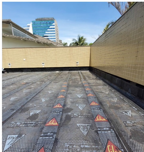
Foto: Execução da camada impermeável Fonte: Sika – Arqª Patricia Bistene
