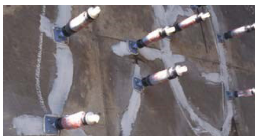
Foto: Injeção de gel vinílico Fonte: Impermaster- Arqº Daniel Montes
