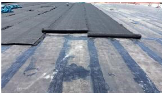
Foto: Imprimação de área
