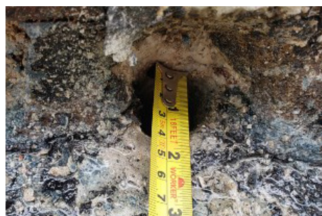
Ilustração e foto: Diâmetro mínimo de 75mm, conforme NBR 9575 Fonte: GTI PROJETOS – Arqª Camila S. Grainho
