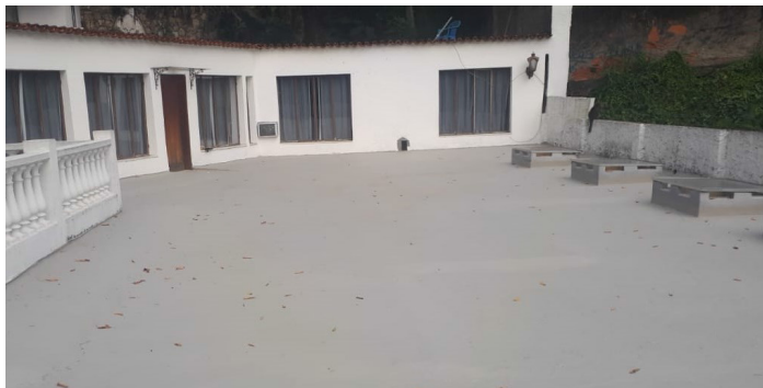
Fotos: Impermeabilização totalmente aderida com membrana acrílica –Icoper HP Fonte: Icobit – Ronaldo Mendonça
