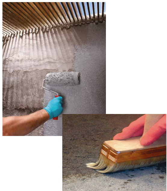
Foto: Membrana cimentícia elastomérica bicomponente para pressão positiva e negativa – Mapelastic Foundation e Primer 3296 Fonte: MAPEI
