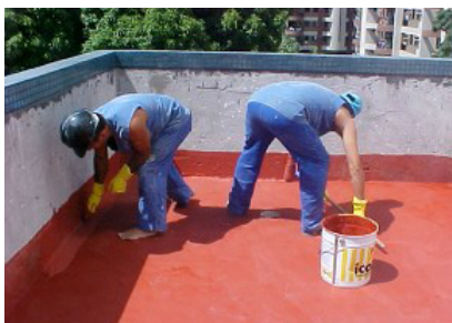
Fotos: Execução da camada impermeável com membrana acrílica- Icopor HP Fonte: Icobit—Ronaldo Mendonça
