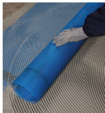
Foto: Patologia devido a falta de impregnação do impermeabilizante na tela Fonte: GTI Projetos – Arqª Camila S. Grainho
