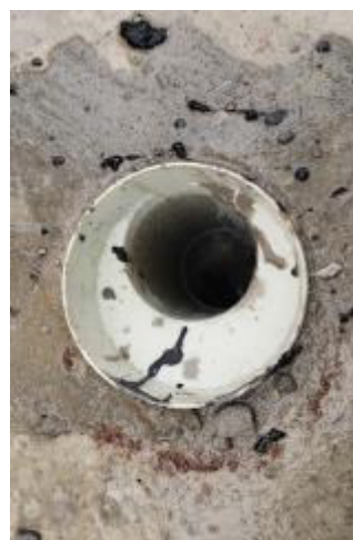
Ilustração e foto: Diâmetro mínimo de 75mm, conforme NBR 9575 Fonte: GTI PROJETOS – Arqª Camila S. Grainho
