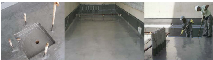
Fotos: Membrana de Poliuretano – Masterpur VD – Masterpol Fonte: Masterpol Tecnologia em adesivo Ltda
