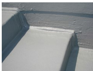
Fotos: Membrana de poliureia aplicada em Estádio Fonte: GTI Projetos – Arqª Camila S. Grainho
