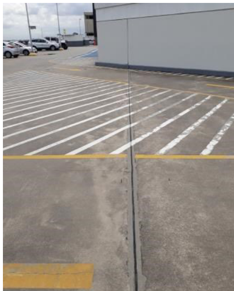
Fotos: Junta de dilatação rebatida no piso final Fonte: GTI PROJETOS - Arqª Camila S. Grainho
