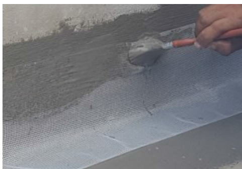
Foto: Véu estruturante em reforço de rodapés Fonte: Hemisfério Produtos Técnicos – Engº Vicente Menta Filho
