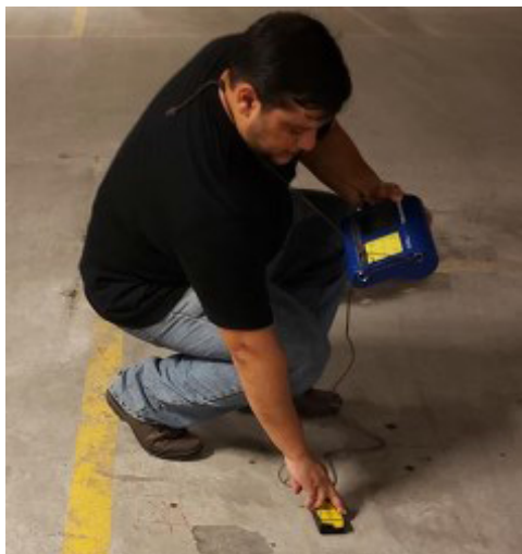
Foto 1: Verificação do recobrimento de armação na laje de subpressão, ensaio: pacometria
