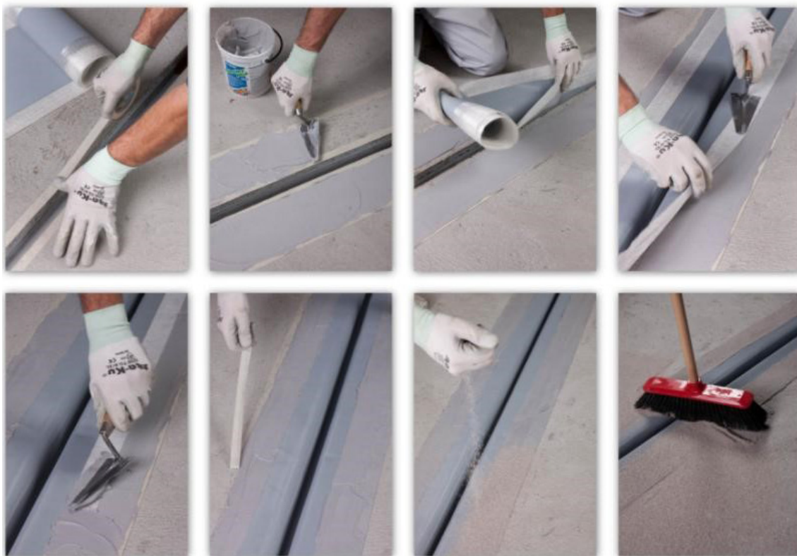
Foto: Fita de TPE para tratamento de juntas de dilatação impermeáveis – Mapeband TPE Fonte: MAPEI
