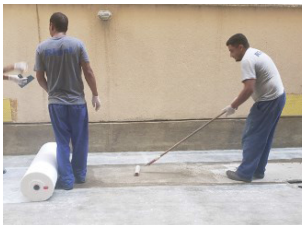
Foto: Execução de Membrana impermeável Fonte: GTI Projetos – Arqª Camila S. Grainho
