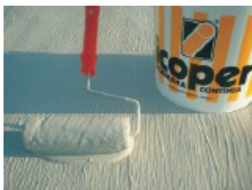
Fotos: Execução da camada impermeável com membrana acrílica- Icopor HP Fonte: Icobit — Ronaldo Mendonça
