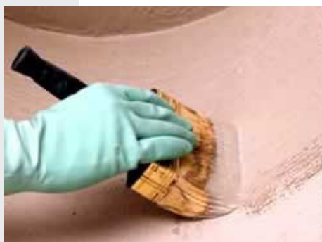
Fotos: Cimentícios com polímeros flexíveis – Produto Mapelastíc Smart Fonte: Mapei
