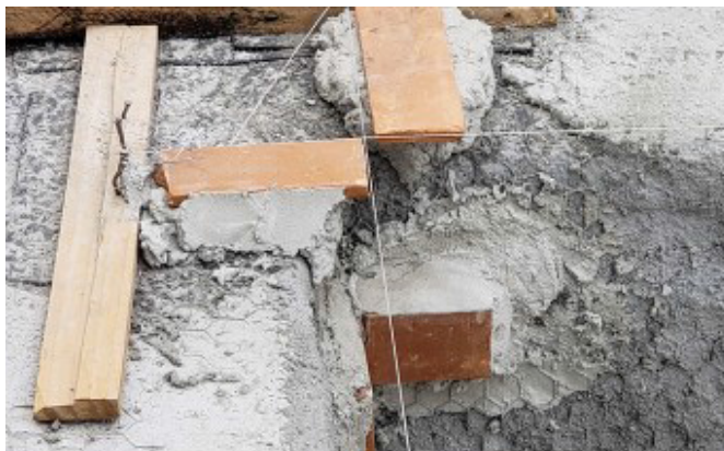
Foto: Exemplo de execução de linhas mestras e taliscas para acertar o nivelamento, prumo e alinhamento
