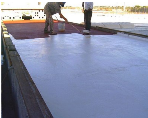
Foto: Tipo de Camada impermeável formulada à base de resinas acrílicas Fonte: ICOBIT – Ronaldo Mendonça
