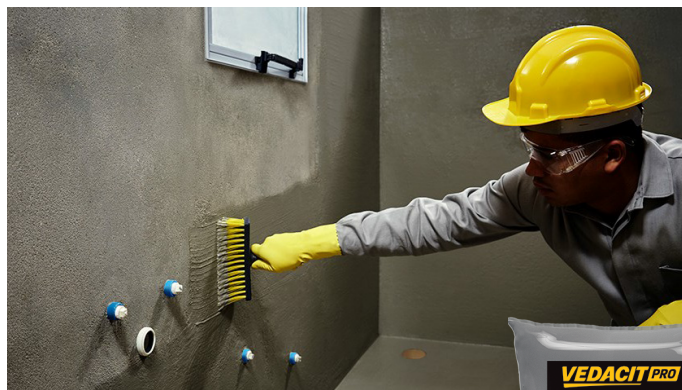
Foto: Aplicação de Cimento modificado com polímero – VEDACIT PRO VEDATOP ARGAMASSA POLIMÉRICA SEMIFLEXÍVEL BASE ACRÍLICA
