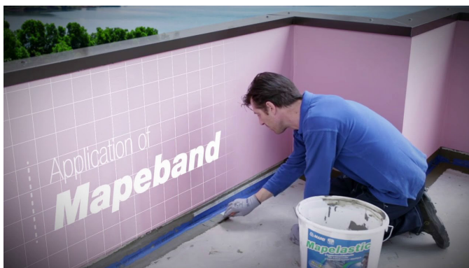
Foto: Fita-Banda: Para encontro de planos – Mapeband Fonte: Mapei
