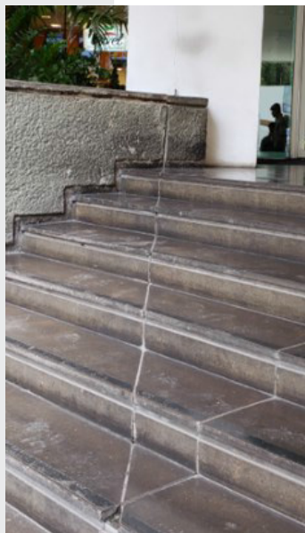
Fotos: Junta de dilatação rebatida no piso final Fonte: GTI PROJETOS - Arqª Camila S. Grainho
