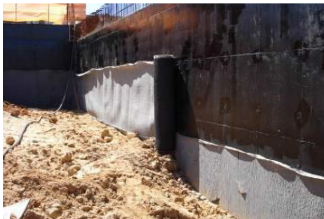
Foto: Camada drenante entre o solo e a Parede
