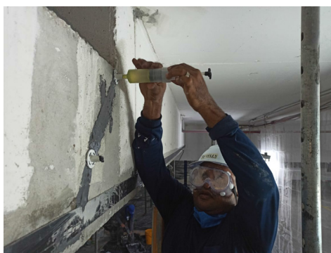
Foto: Injeção de epóxi em baixa pressão
