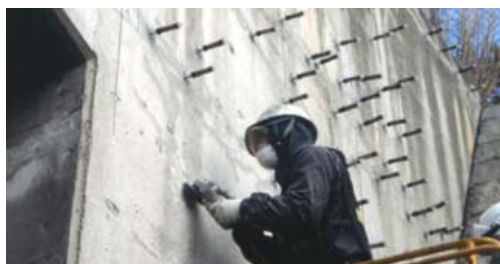
Fotos: Bicos de injeção Fonte: Mastercoin
