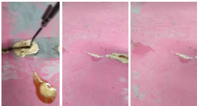
Fotos: Injeção de espuma de poliuretano e resina de poliuretano Fonte: Rigel – Engº Igor Pitanga
