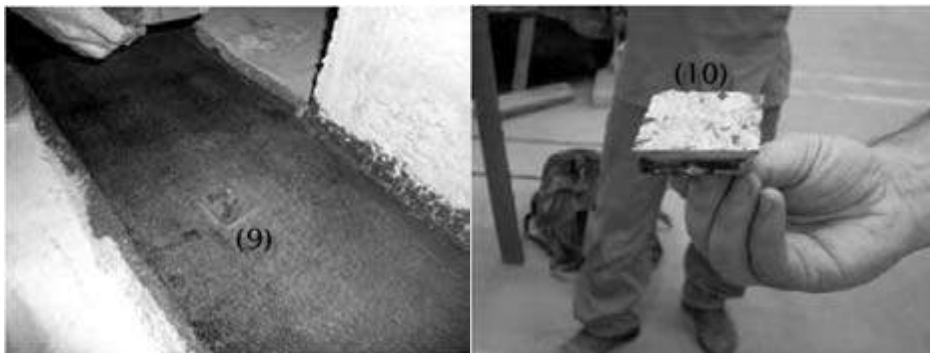
Fotografia 3.12 – Fases construtivas (9) e (10).
