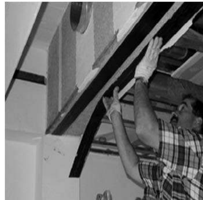
Fotografia 9.15 – Reforço de viga com laminado de fibra de carbono.
