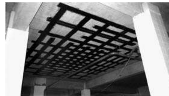
Fotografia 2.2 – Reforço de lajes à flexão nas duas direções.
