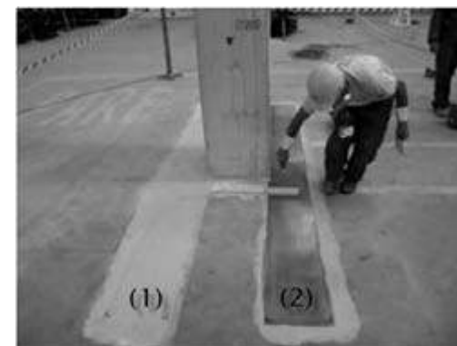
Fotografia 3.6 – Fases construtivas (1) e (2).
