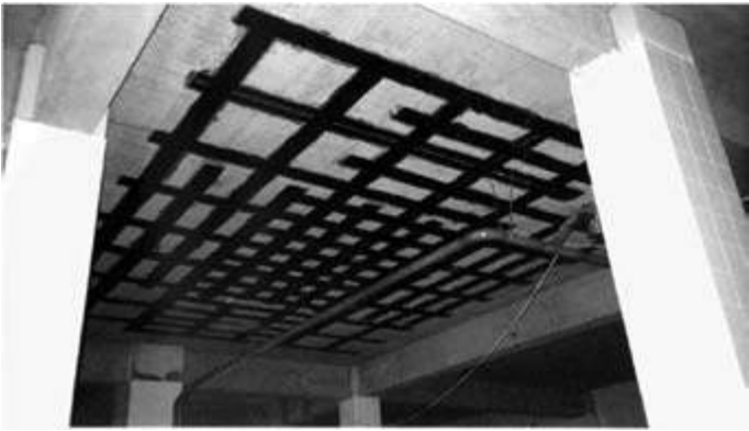
Fotografia 9.2 – Reforço de laje de instalação industrial para permitir a instalação de novos equipamentos.
