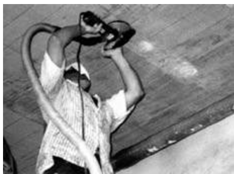
Fotografia 3.1 – Limpeza de superfície com politriz elétrica.
