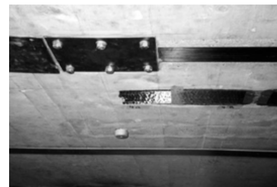
Fotografia 6.2 - Ancoragem complementar de laminado.
