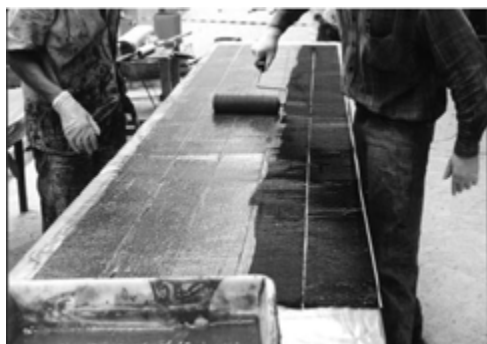
Fotografia 3.3 – Saturação da fibra de carbono na bancada.
