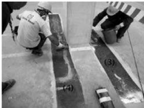
Fotografia 3.7 – Fases construtivas (3) e (4).
