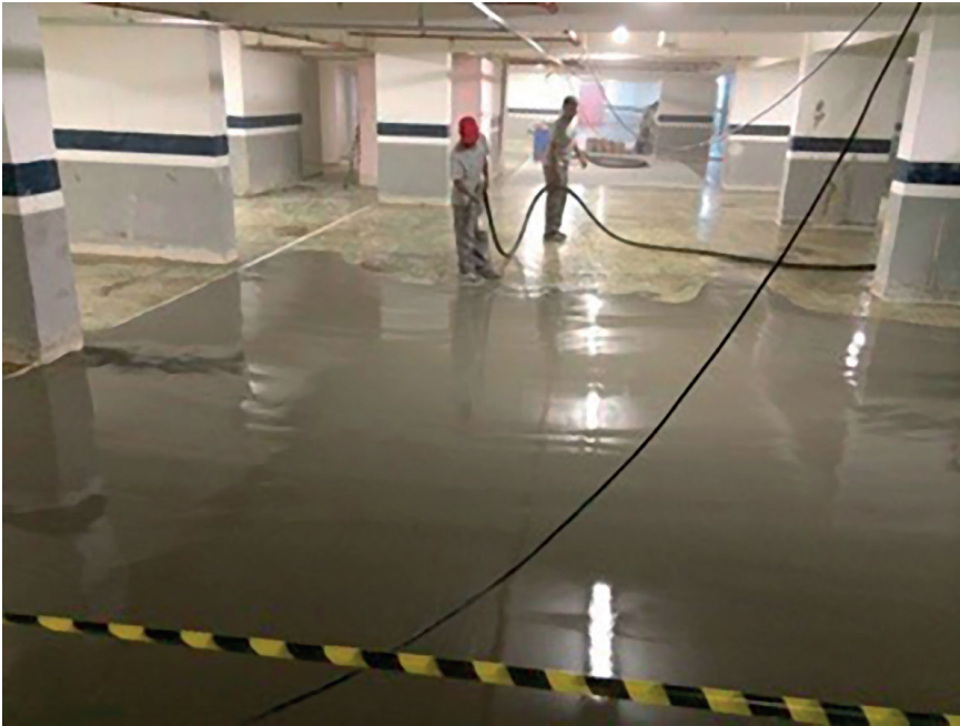
Foto 6 – Reparo de piso de concreto com argamassa cimentícia autonivelante.
