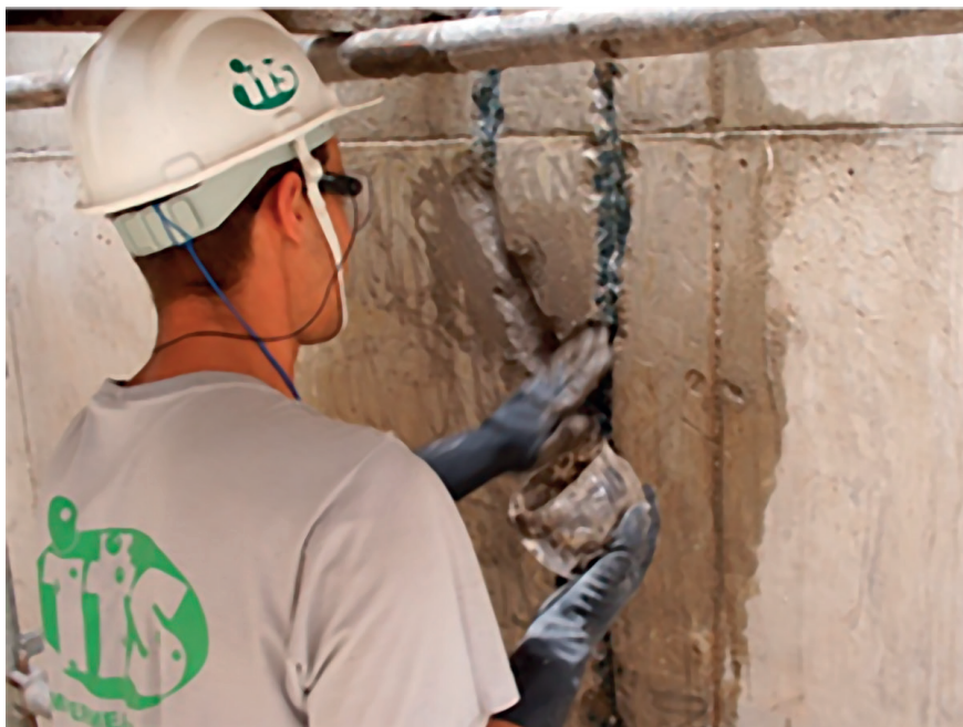
Foto 3 – Tratamento de infiltração pela parede do subsolo com argamassas de cristalização integral PENETRON.
