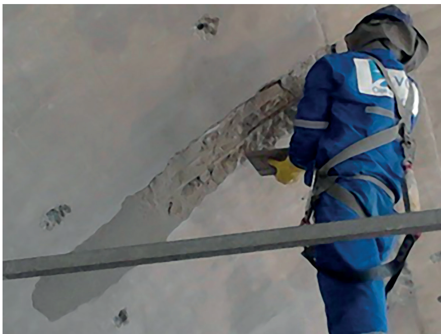
Foto 4 – Reparo estrutural com argamassa polimérica PATCHLINE SM.
