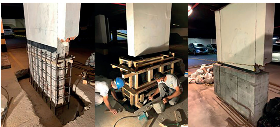
Foto 5 – Recuperação de pé de pilar e proteção com PENETRON GROUT.
