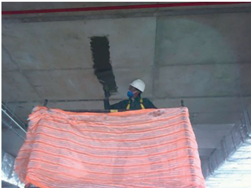
Foto 1 – Tratamento de infiltração com argamassa de cristalização integral PENETRON.
