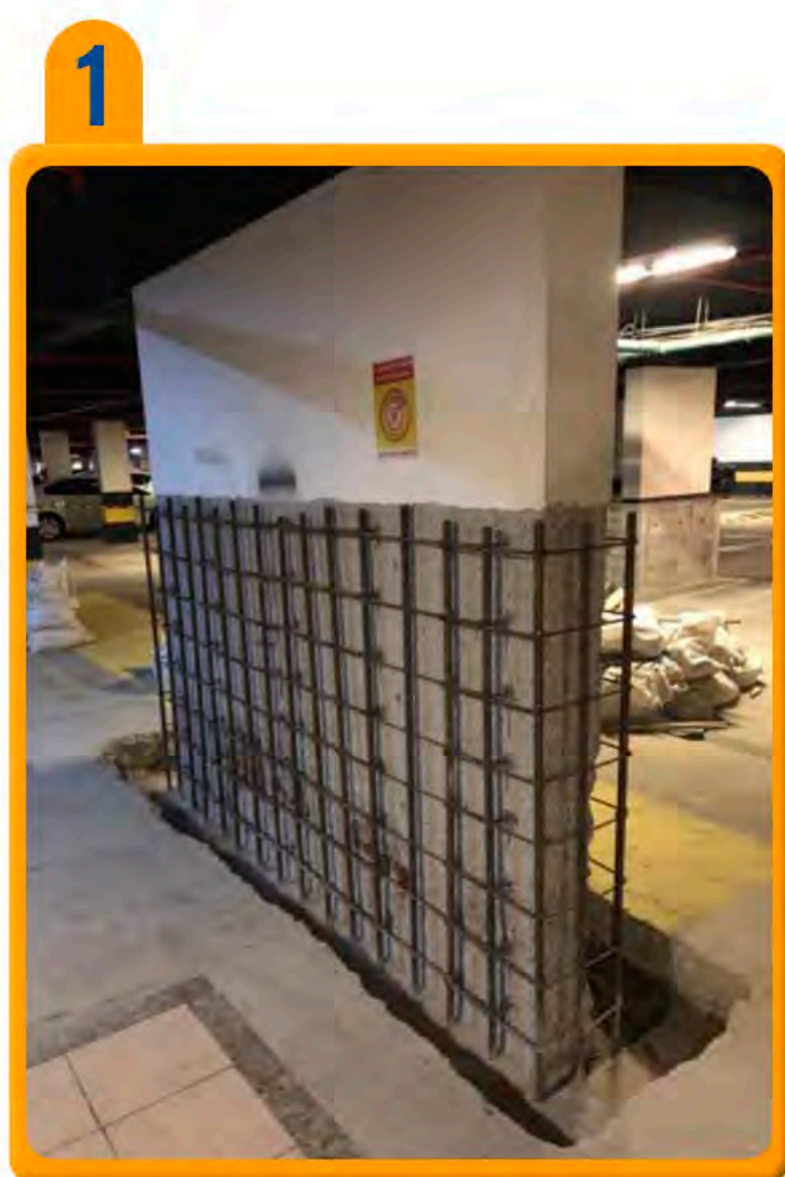
1 Encamisamento de pilar de edifício com PENETRON GROUT. Fonte: Penetron Brasil.
