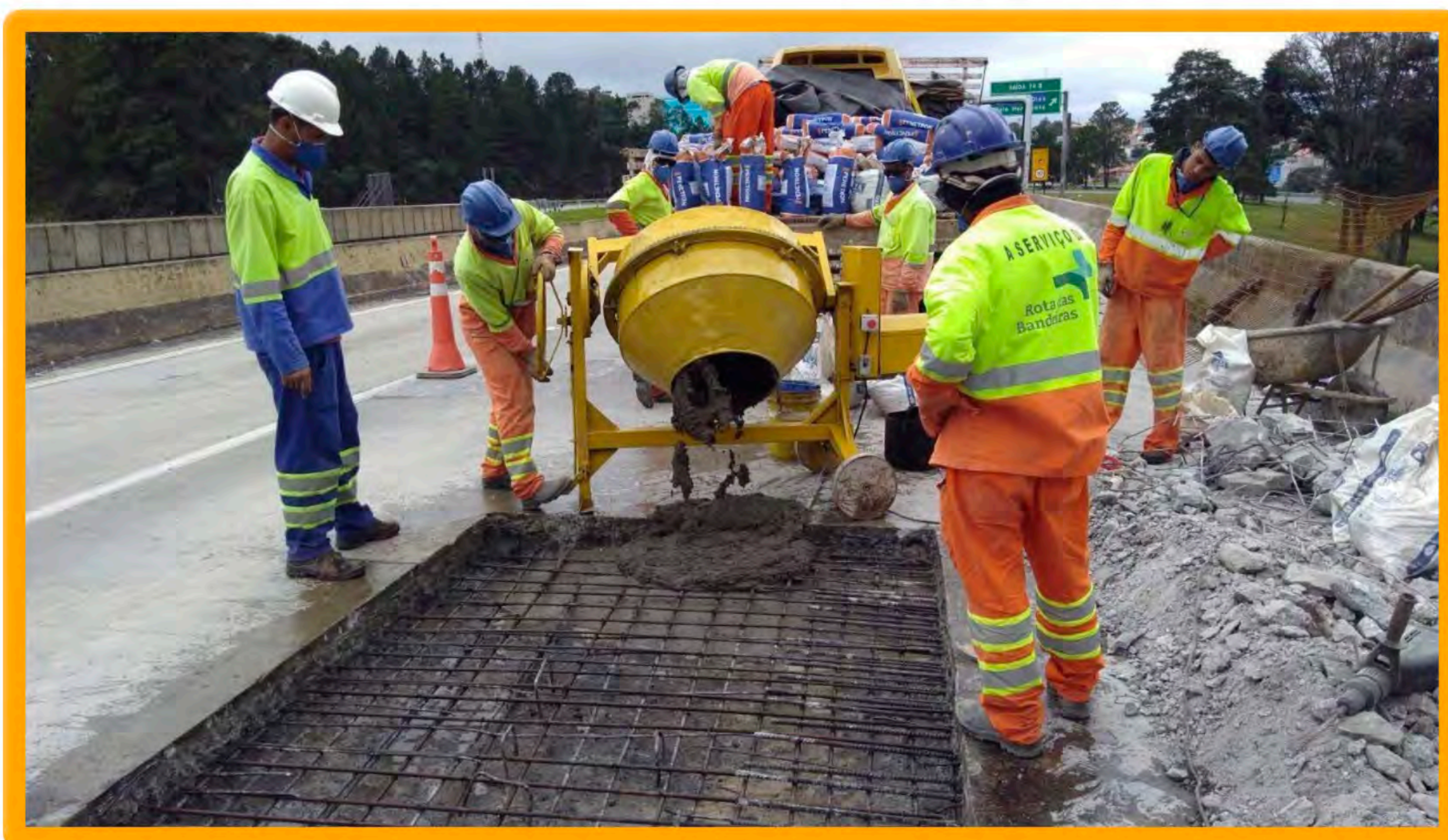
Reparo profundo em pavimento rígido da rodovia Dom Pedro I (SP). Fonte: Penetron Brasil.
