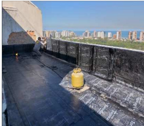
Foto 1: Aplicação de manta com maçarico.
