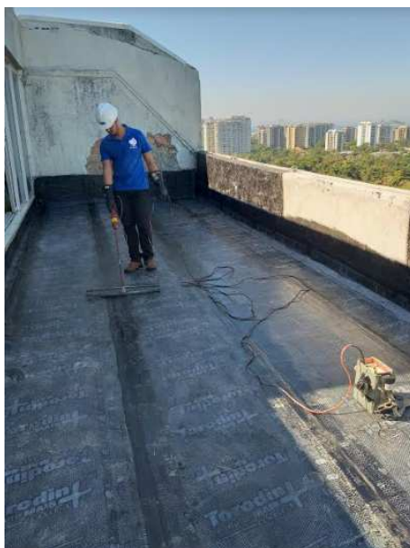
Foto 3: Execução do teste de descontinuidade
